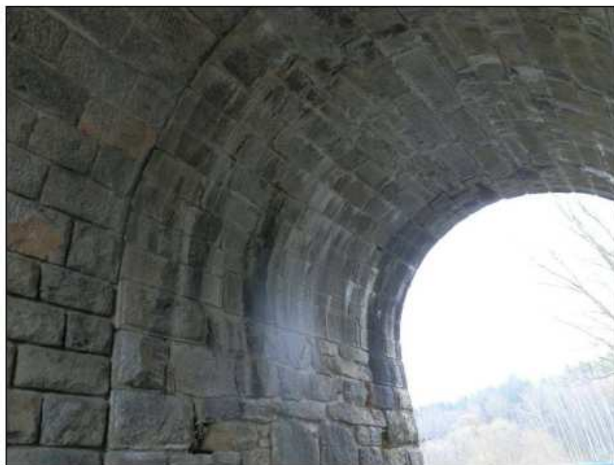
Obr. č. 7 - klenba nad pravou původní částí, zdivem prosakuje voda (usazeniny na líci)
