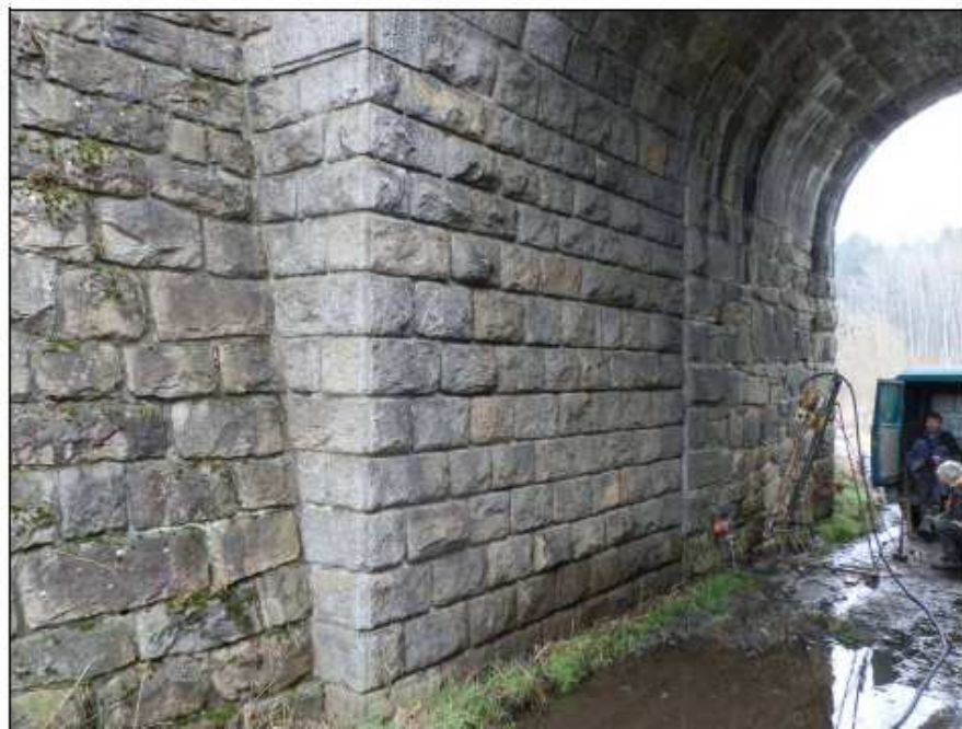
Obr. č. 6 - oprav Nepomuk, pravá (vzdálenější) strana opěry je původní
