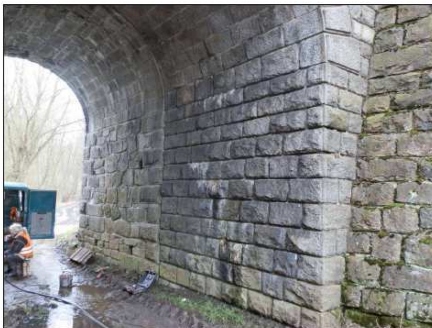
Obr. č. 5 - opěra Strakonice, uprostřed opěry viditelná svislá dilatační spára, pravá (vzdálenější) strana je původní
